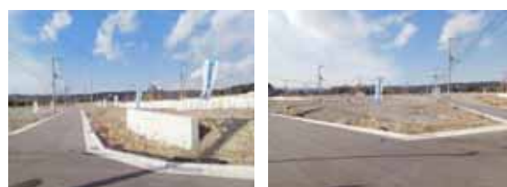
現地写真：28街区、29街区
