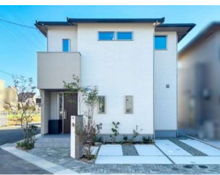
太陽光発電(3.48kW)、オール電化住宅
