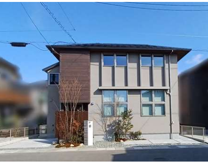
太陽光発電(4.48kW)、オール電化住宅
