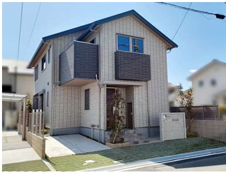
太陽光発電(3.88kW)、エネファーム
